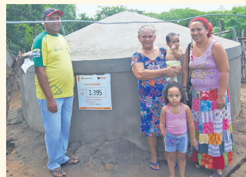
Eine Zisterne deckt den Wasserbedarf für den Hausgebrauch und den Garten einer ganzen Familie für rund acht Monate.
